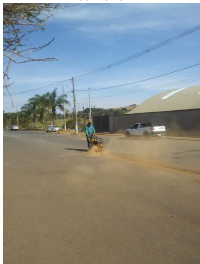
Figura 7: Área onde será construído o canteiro.
