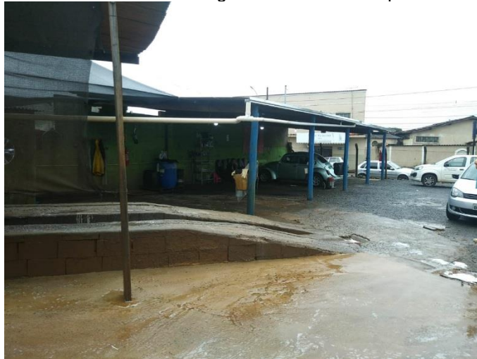
Foto 05: Piso da área de lavagem dos veículos impermeabilizado.
