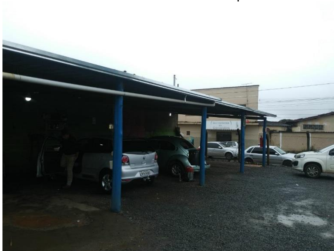
Foto 02: Vista da área interna do empreendimento.
