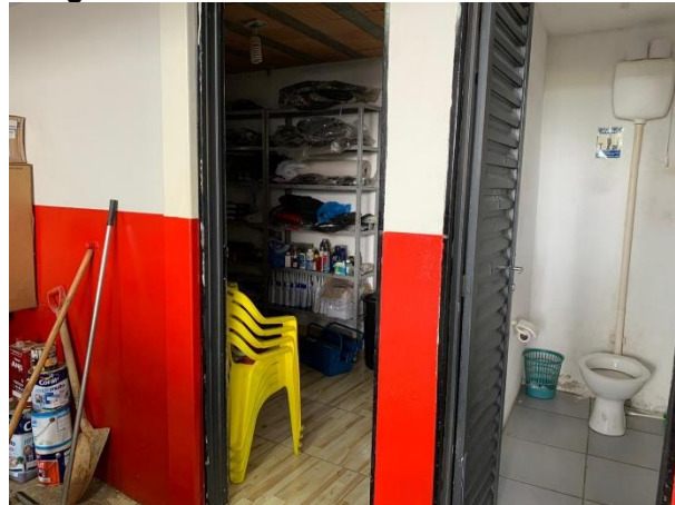
Figura 07: Vista do banheiro dos funcionários.
