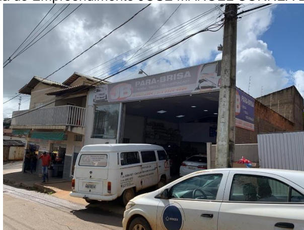
Fonte: SISMAM. Registro em 09 de março de 2020.
