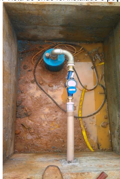
Figura 06: Vista de onde foi instalado o poço artesiano
