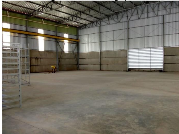
Figura 04: Vista do galpão.
